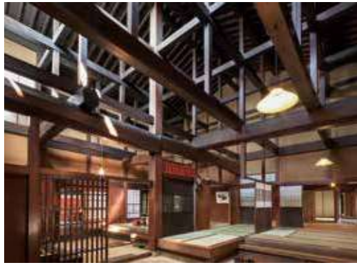
飛騨匠が残した技術が民家建築の中に息づく「吉島家住宅」
