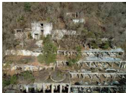
大谷鉱山巨大精錬所跡(宮城県気仙沼市)
