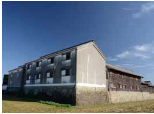
藍屋敷(田中家住宅)
