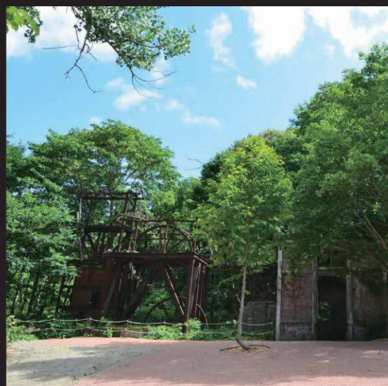
旧幾春別炭鉱錦立坑
