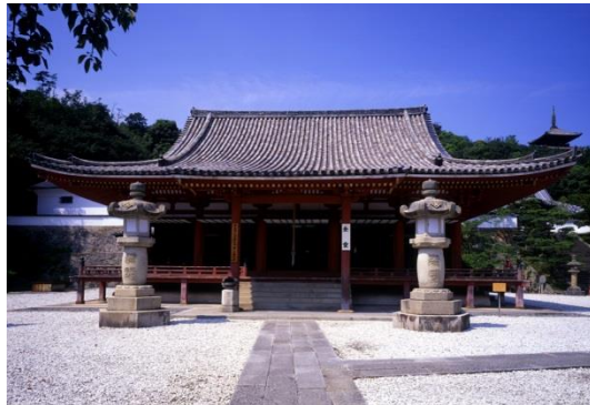
④ 西國寺金堂、三重塔
