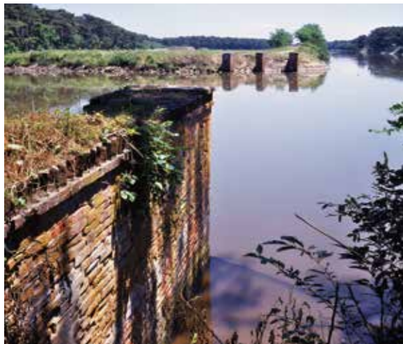
大規模な港湾建設計画が中止され、貴重な遺構が残っていた野蒜築港跡だが、2011年の東日本大震災によりその多くが流失・損壊してしまう。写真は1999年6月に撮影された野蒜築港の遺構(撮影:西山芳一)
