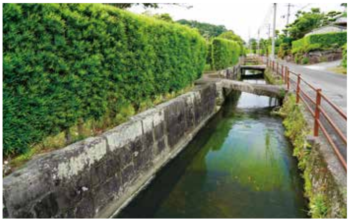
益山用水路 1768年、25代島津重豪の時代に、藩の事業として完成。幅2m、高さ1.7mの水路を竹田神社から益山まで約5km導いて、200haの水田を潤しました。
