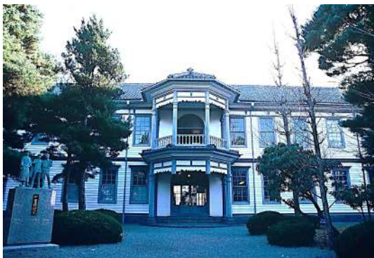
33 旧福島県尋常中学校本館
