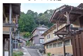
西山工場(丹後最古のちりめん工場)
