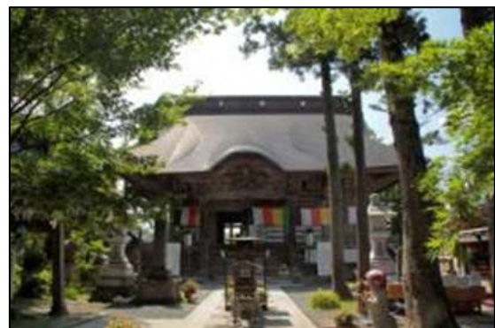
36 如法寺観音堂 附 仁王門 (西会津町)
