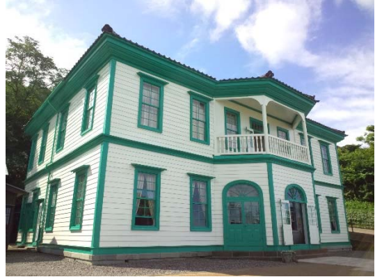
4. 旧檜山爾志郡役所庁舎
