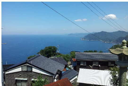
⑨ 因幡・但馬沿岸の岩石海岸の漁村集落 (崖上に立地する御崎集落)
