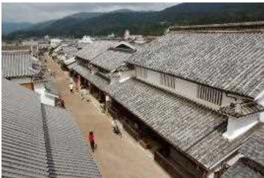
28-1. 美馬市脇町南町伝統的建造物群保存地区 (うだつの町並み)
