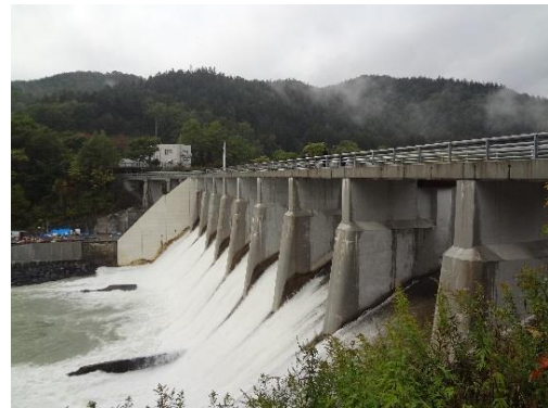
⑮旧北炭清水沢水力発電所
