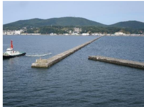
㉑小樽港北防波堤
