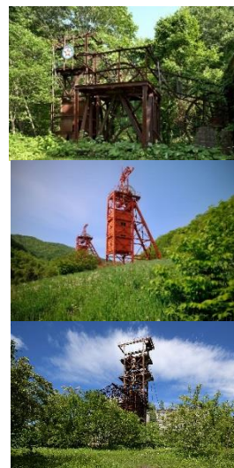
技術開発により進化する立坑
