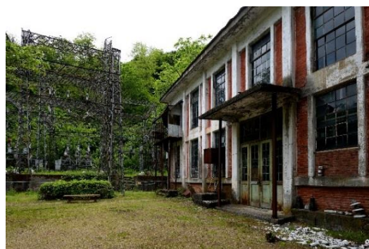
⑨幌内変電所
