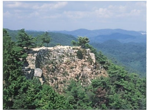
鬼城山の絶壁上に築かれた石垣(総社市)
