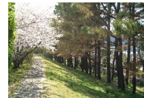
土で固めた堤防(広村堤防)
