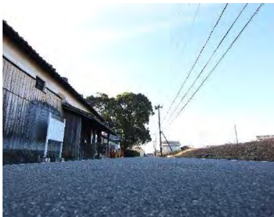
① 生野鉦山寮馬車道跡 (姫路市)
