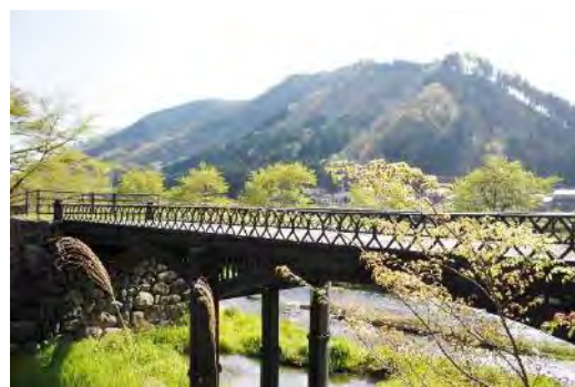
⑪ 羽淵鑄鉄橋
