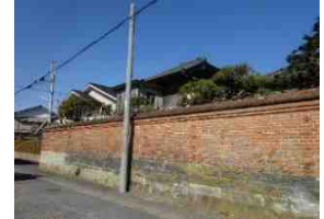
4-4 煉瓦塀(国登録西廣家住宅)
