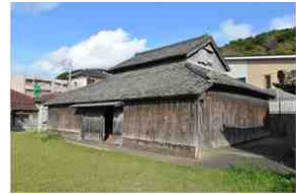
4-4 倉庫(国登録西廣家住宅)
