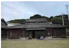
4-4 倉庫(国登録西廣家住宅)
