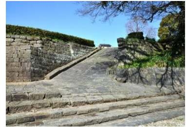
高瀬船着場：船へ向かって米俵を転がす
