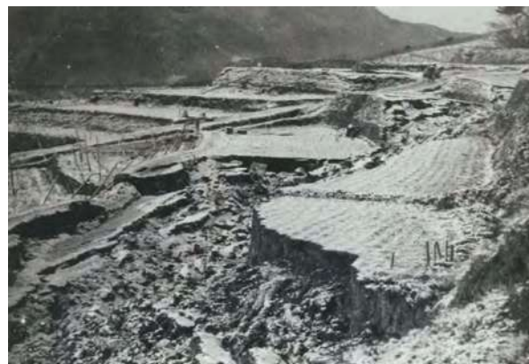
昭和7年の地すべりによる地割れの様子
