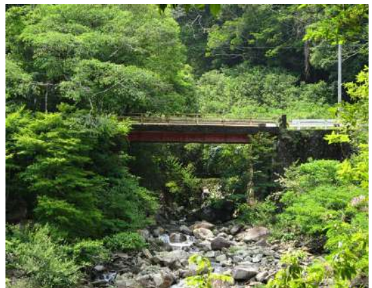
㉒ 釜ヶ谷橋
