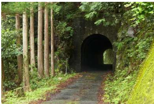
⑲ オオムカエ隧道
