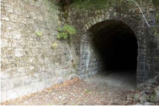
⑳ 平瀬隧道
