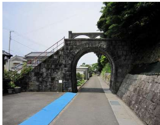
③④ 法恩寺跨線橋
