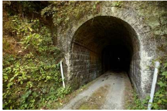
㉑ 河口隧道
