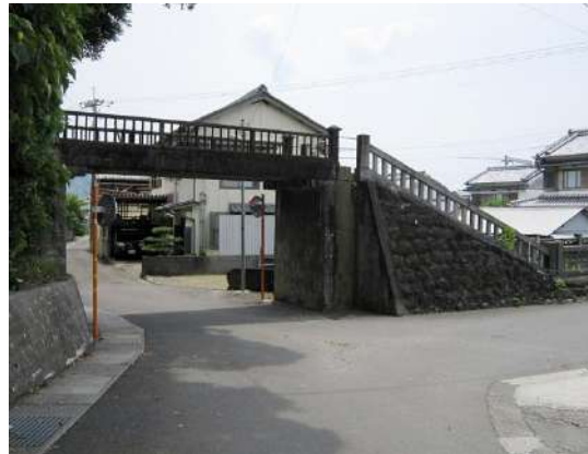
③② 八幡山跨線橋
