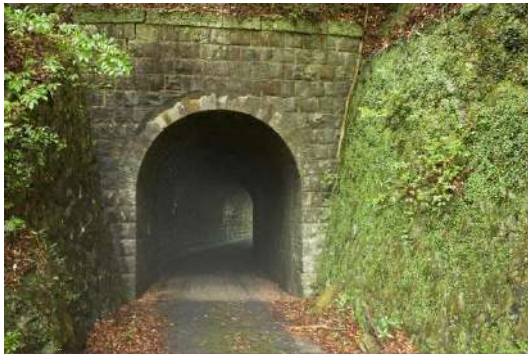
⑱ バンダ島隧道
