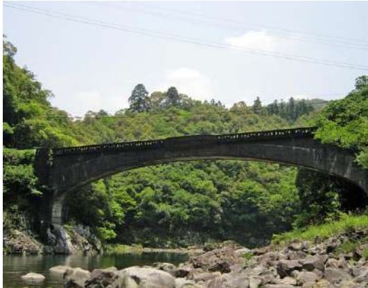
②⑨ 堀ヶ生橋
