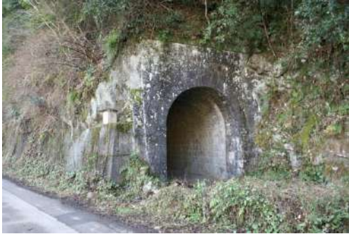
⑰ エヤ隧道
