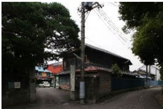
⑱ イサミコーポレーションスクール工場・ 事務所・土蔵・モルタル蔵・木造倉庫
