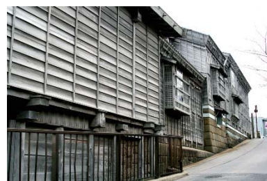
傾斜地に階段状に下がっている蔵と小路
