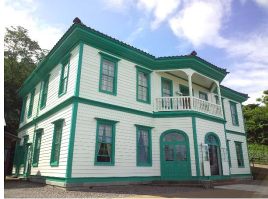
4. 旧檜山爾志郡役所庁舎
