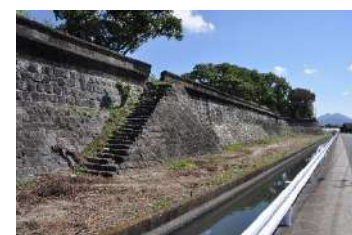
海辺：5.2km連なる旧玉名干拓施設の一部 明五開潮受堤防
