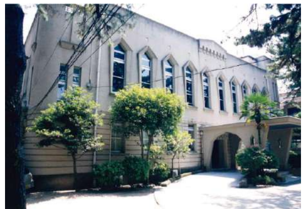
⑤⑪ 私立灘中学校・高等学校本館
