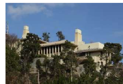
「旧山邑家住宅（淀川製鋼迎賓館）」
