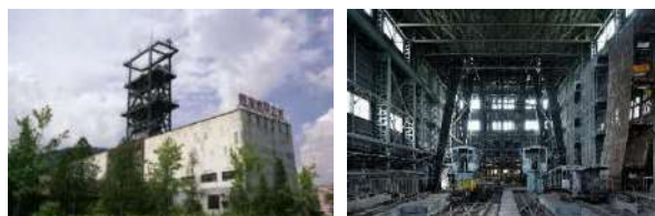
住友赤平炭鉱立坑櫓とその内部
