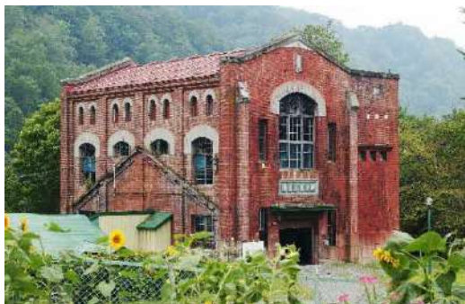
⑫旧北炭滝ノ上水力発電所
