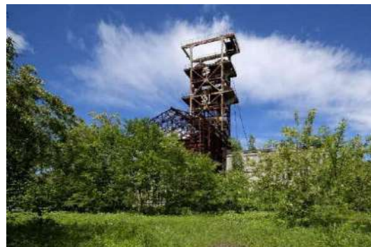
㉒住友奔別炭鉱立坑櫓・周辺施設
