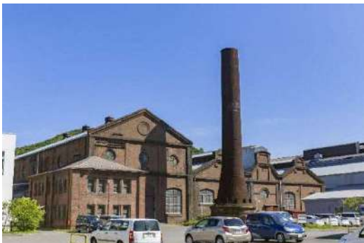
②④旧火力発電所（日本製鋼所）
