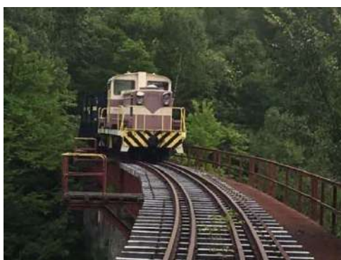
⑭ 旧三井芦別鉄道炭山川橋梁
