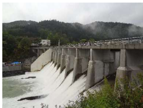
⑮旧北炭清水沢水力発電所
