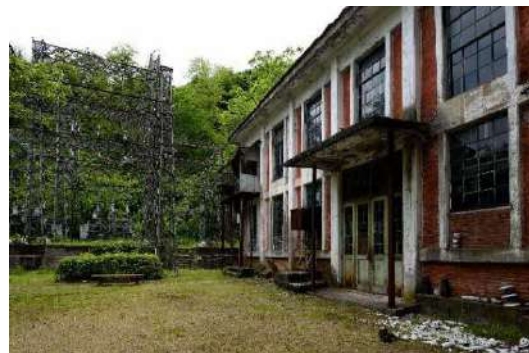
⑨幌内変電所
