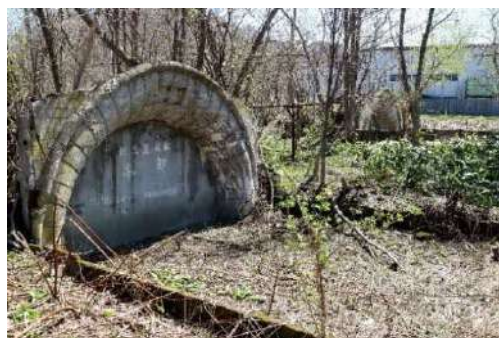
⑬北炭新幌内砦坑口
