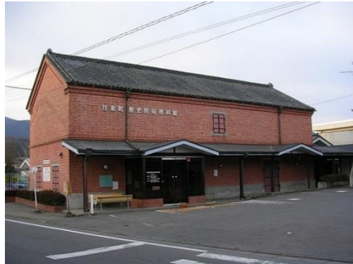
④ 旧小幡組製糸レンガ造り倉庫
