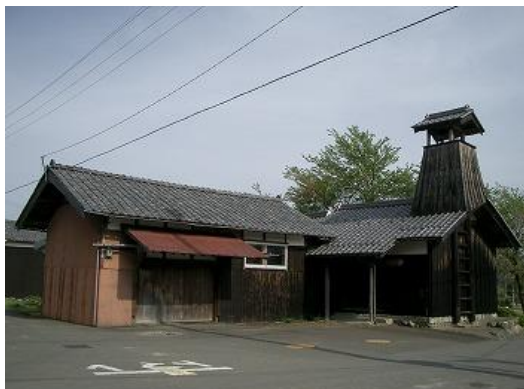
5 三宅の火の見やぐら、火の見やぐら倉庫
