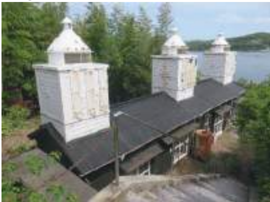
37-⑦-3 通航信号塔
