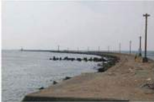
25-⑦ 三国港（旧阪井港）突堤
