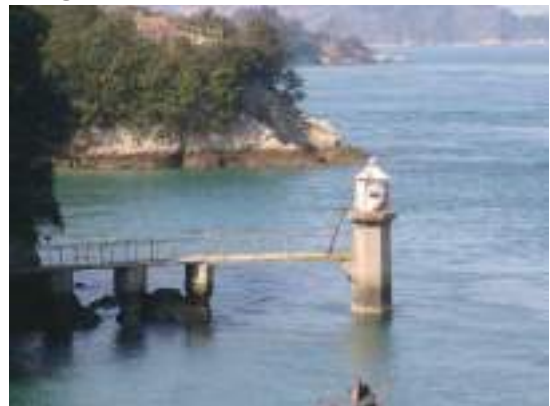
37-⑦-5 検潮器浪除塔
