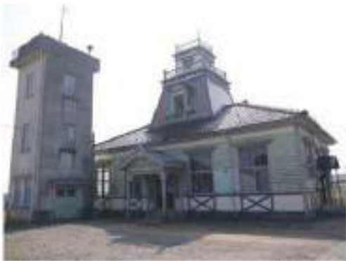
22-② 旧伏木側候所庁舎・測風塔
