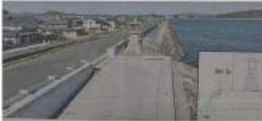
52-⑫-1 旧九幡港常夜燈（移設後の計画写真／令和7年度末移設予定）
