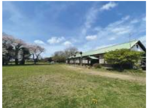
③⑤旧岡田小学校女化分校校舎
