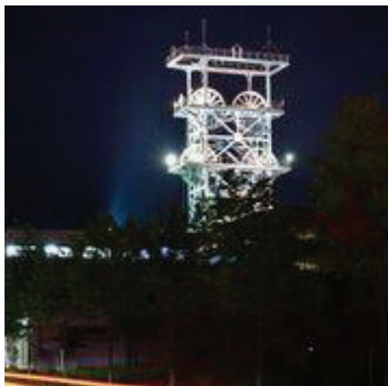
②③ 住友赤平炭鉱立坑櫓・周辺施設
