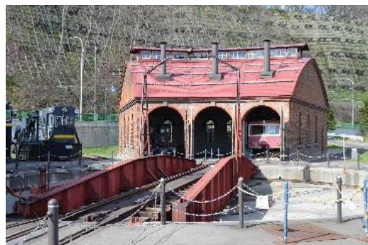
⑮旧手宮鉄道施設 (機関車庫三号)
