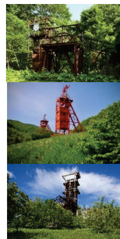
技術開発により進化する立坑
