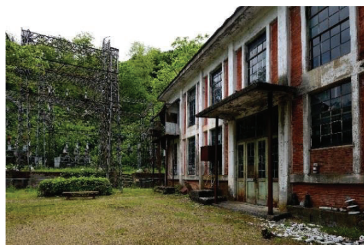
⑨幌内変電所
