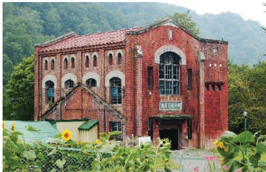
⑫旧北炭滝ノ上水力発電所
