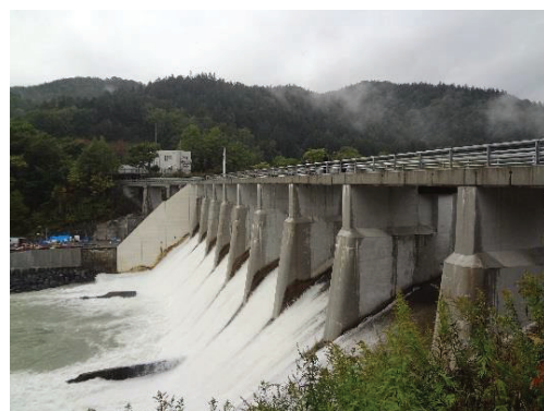
⑮旧北炭清水沢水力発電所
