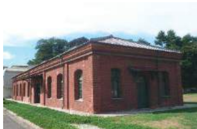
2-18 海上保安大学校煉瓦ホール(旧呉海軍工廠砲煩部火工場機械室)
