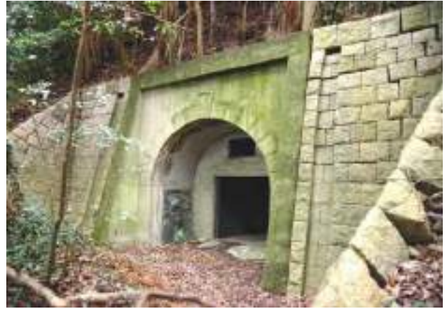
4-27 舞鶴鎮守府島嶼施設 (蛇島ガソリン庫)
