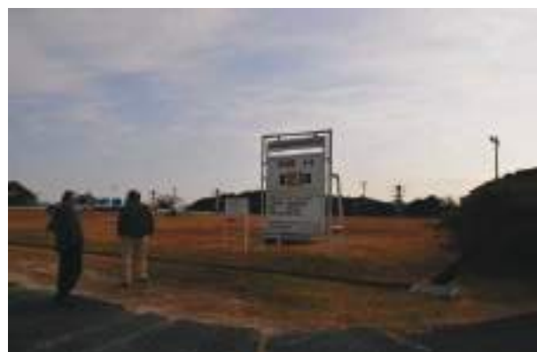
3-10 庵崎貯油所地下重油槽
