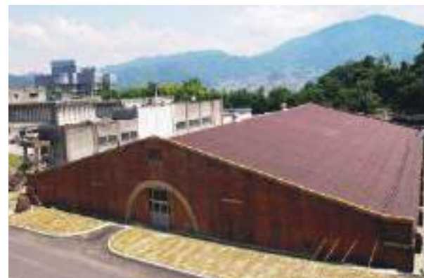
2-6 呉市水道局宮原浄水場低区配水池
