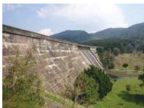
3-18 佐世保市水道局水道施設群(菰田貯水池堰堤)
