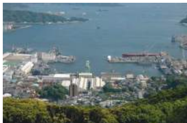
3-6 立神係船池(旧修理艦船繫留場)
