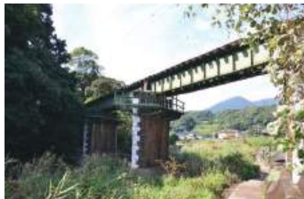
3-16 清水の瀬橋梁
