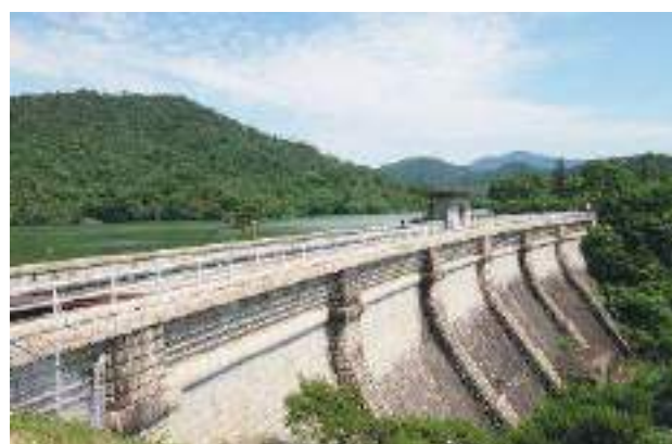
2-5 本庄水源地堰堤水道施設 堰堤，丸井戸，第一量水井，階段
