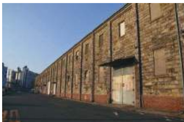
3-3 西九州倉庫(株)前畑1号倉庫(旧第五水雷庫)
