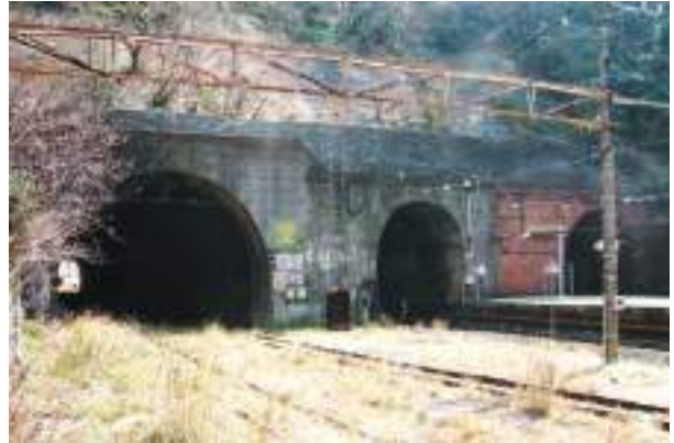
1-15 しつかま 七釜トンネル
