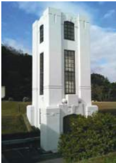
1-14b へみ 逸見浄水場 配水池入口
