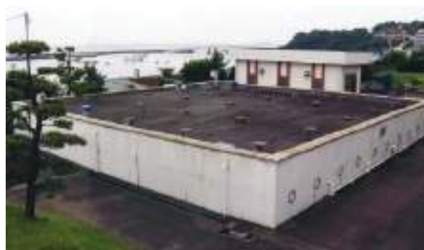
1-13b 走水水源地 鉄筋コンクリート造浄水池
