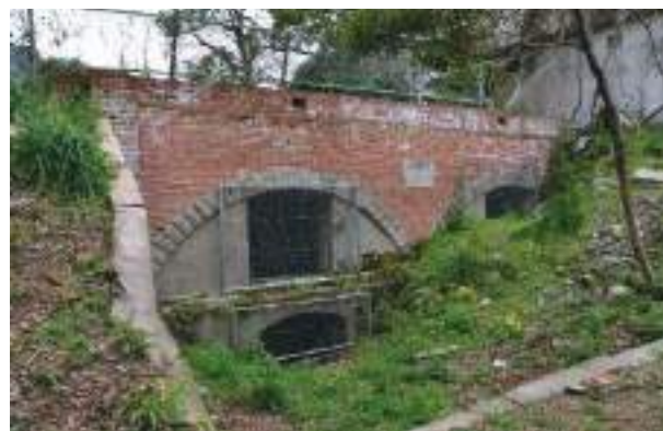
3-17 佐世保鎮守府水道施設群(矢岳貯水所)
