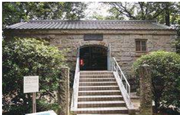
2-10 呉市入船山記念館旧高鳥砲台火薬庫
