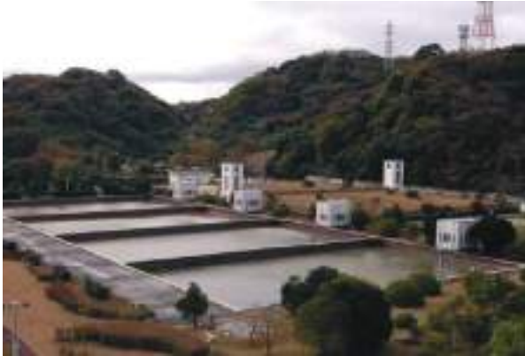
1-14a へみ 逸見浄水場
