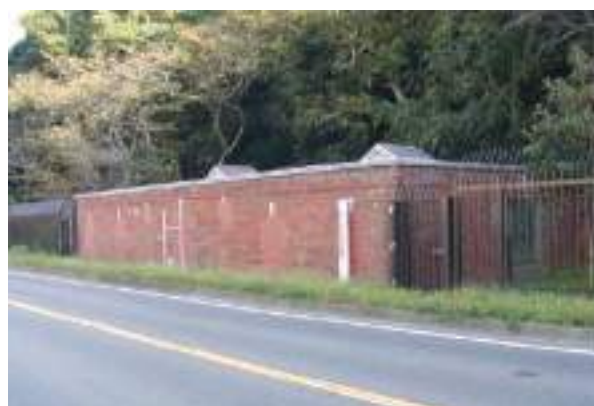
1-13a 走水水源地 煉瓦造貯水池
