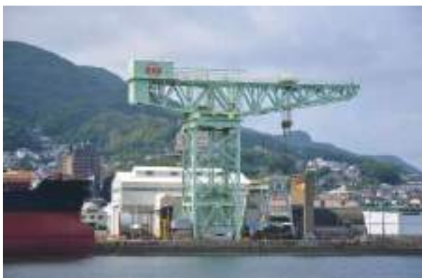
3-7 佐世保重工業(株)250トンクレーン
