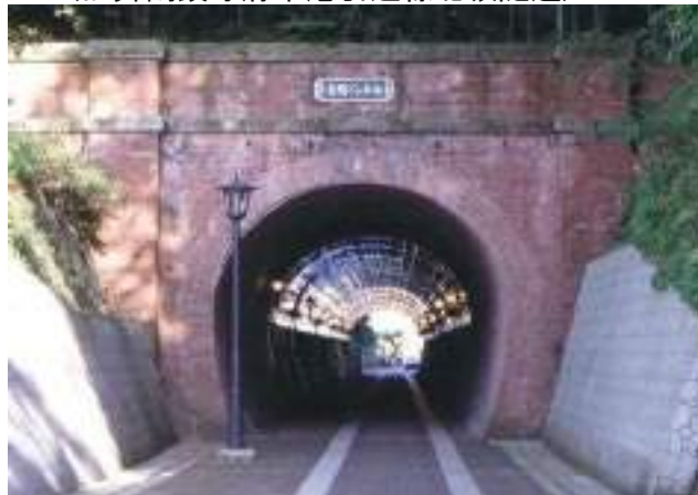
4-8 市道北吸・桃山線北吸トンネル (旧舞鶴鎮守府軍港引込線北吸隧道)
