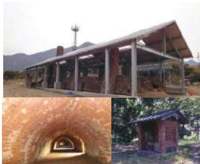
4-19 神崎煉瓦ホフマン式輪窯及び湊十二社手洗所 (旧京都竹村丹後製窯所煉瓦窯及び湊十二社手洗所)
