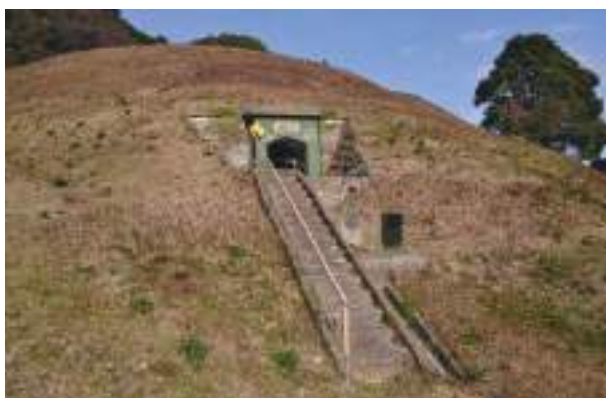
3-9 赤崎貯油所旧地下重油槽
