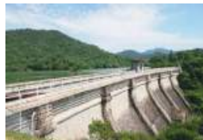
呉市本庄水源地堰堤水道施設 1920 年
