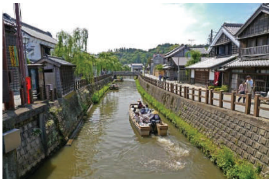
3-1 伝統的な町並み (佐原重要伝統的建物群保存地区)
