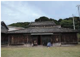
4-4 倉庫 (国登録旧西廣家住宅)
