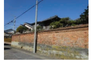
4-4 煉瓦塀 (国登録旧西廣家住宅)
