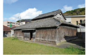
4-4 倉庫 (国登録旧西廣家住宅)
