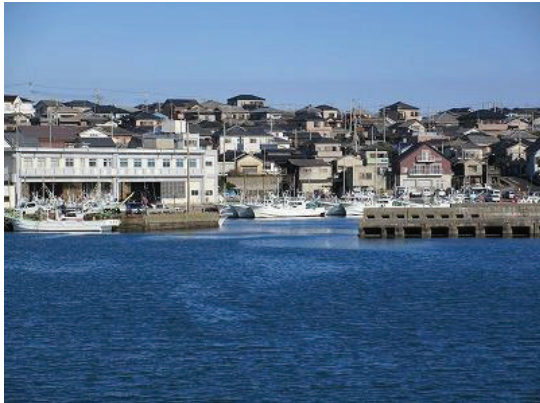
4-1 斜面に基盤目状に造られた 外川の町並み
