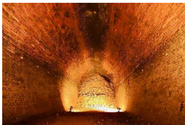
亀の瀬トンネルの崩落面
