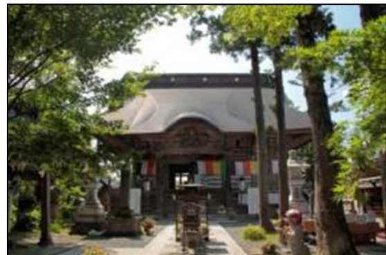
36 如法寺観音堂 附 仁王門 (西会津町)
